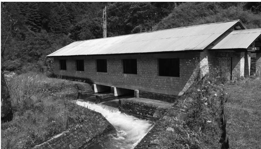
FIGURE 2.33 Tailrace of a 400-kW mini hydropower plant, Nepal.
